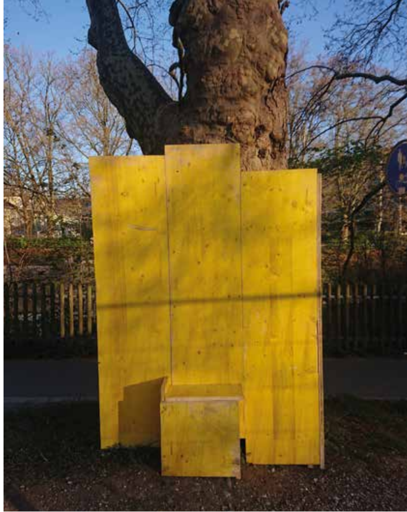
Foto 1: Stambescherming uit schaaldelen met extra uitstulping voor zware wortelaanloop.
